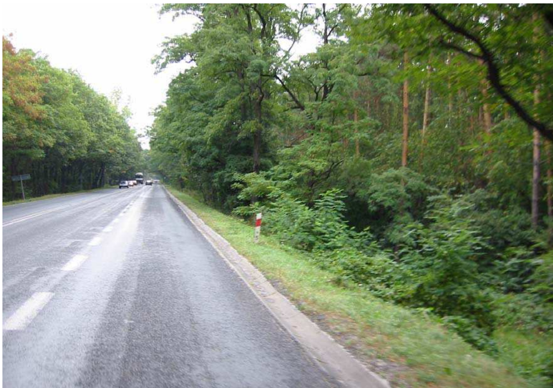
Fot. 61. Przykład usytuowania elementu odwodnienia (rynnę ściekową), bezpośrednio przy jezdni – pobocze nieutwardzone na tym odcinku drogi nie podlega ocenie.
