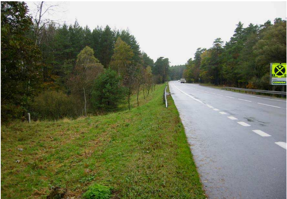
Fot. 72. Kolejny przykład odwodnienia naturalnego na jednej z dróg krajowych.
