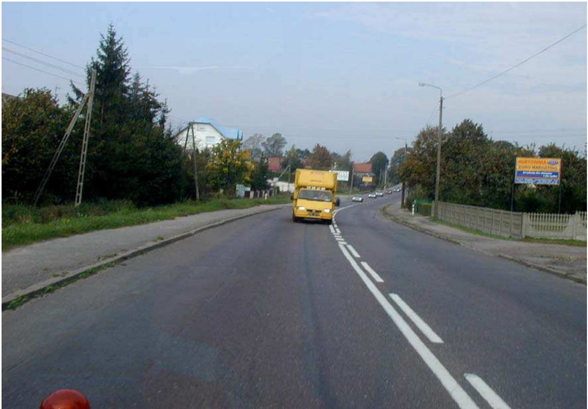
Fot. 73. Odwodnienie naturalne (spadek podłużny) w przekroju ulicznym.
