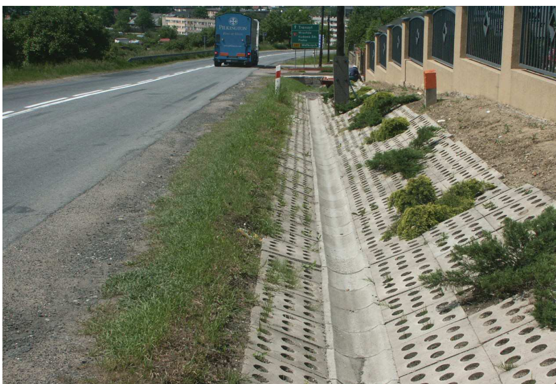
Fot. 2. Odnowiony ciąg odwodnienia.
