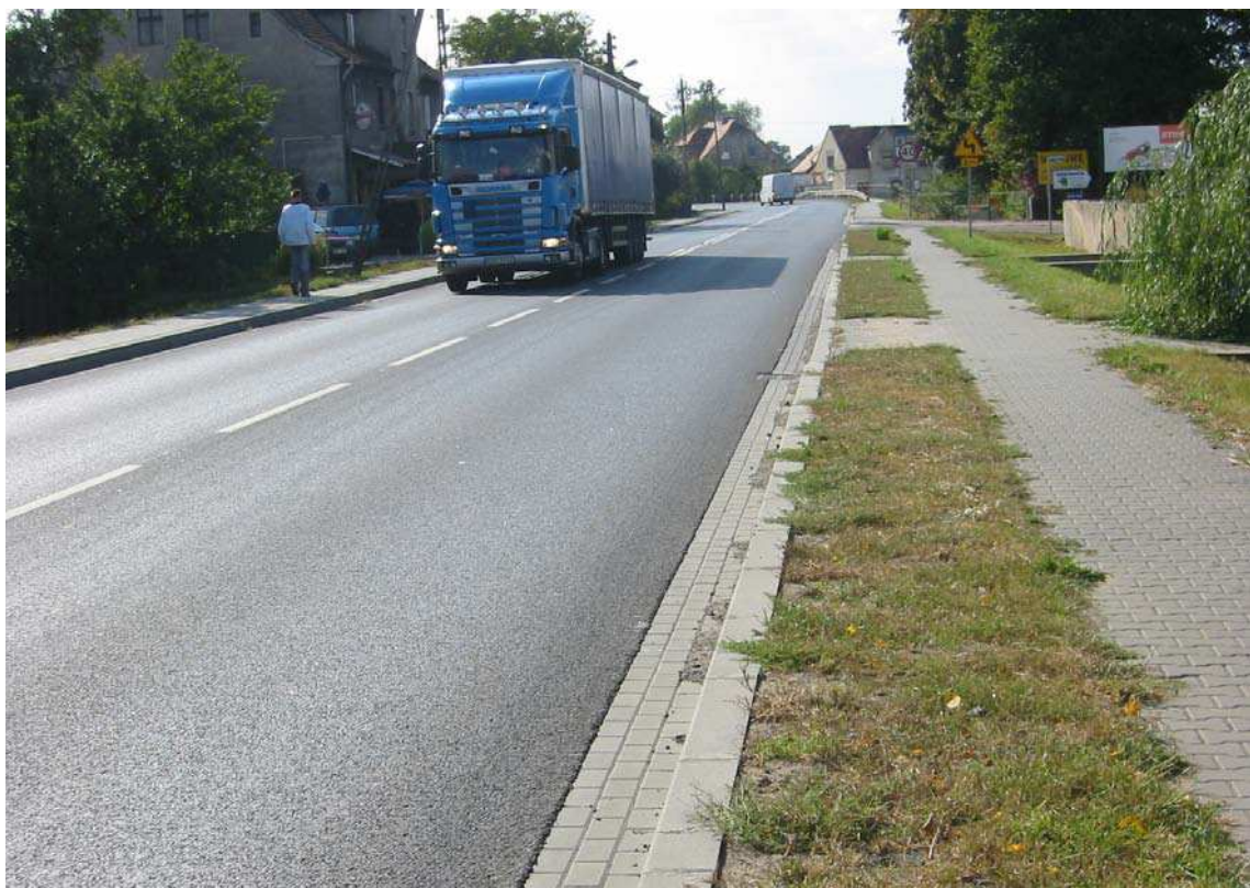
Fot. 62. Brak pobocza nieutwardzonego – przykład przekroju ulicznego. W formularzu wpisujemy w kolumnie nr 3 kod „u” oraz w kolumnie nr 4 (ocena) kod 6.
