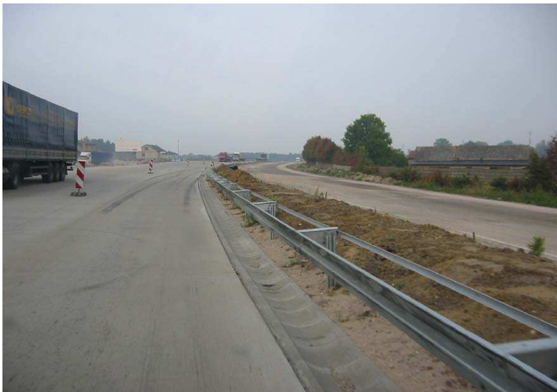
Fot. 1. Rynny odprowadzające na wyremontowanym odcinku drogi o nawierzchni betonowej.
