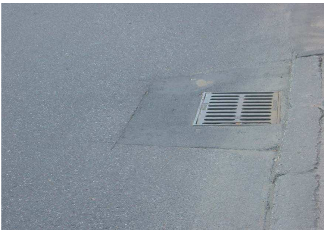
Fot. 33. Studzienka w dobrym stanie technicznym (po wykonanym remoncie).
