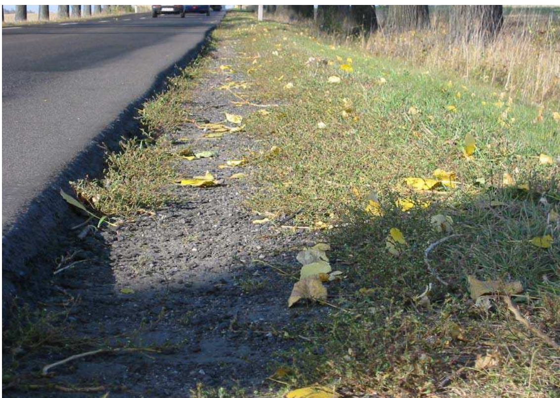
Fot. 49. Pobocze z uskokiem przekraczającym 15 cm.
