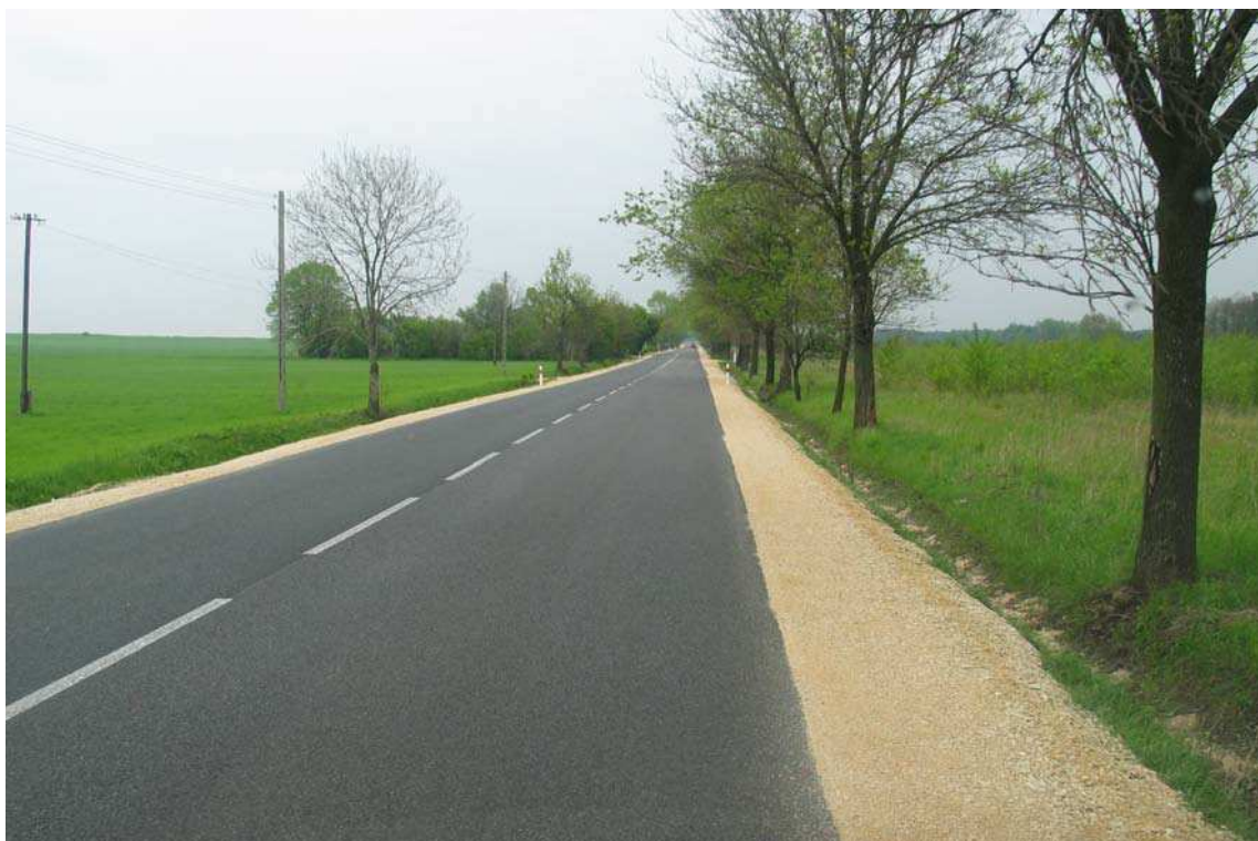
Fot. 40. Przykład pobocza w dobrym stanie technicznym.
