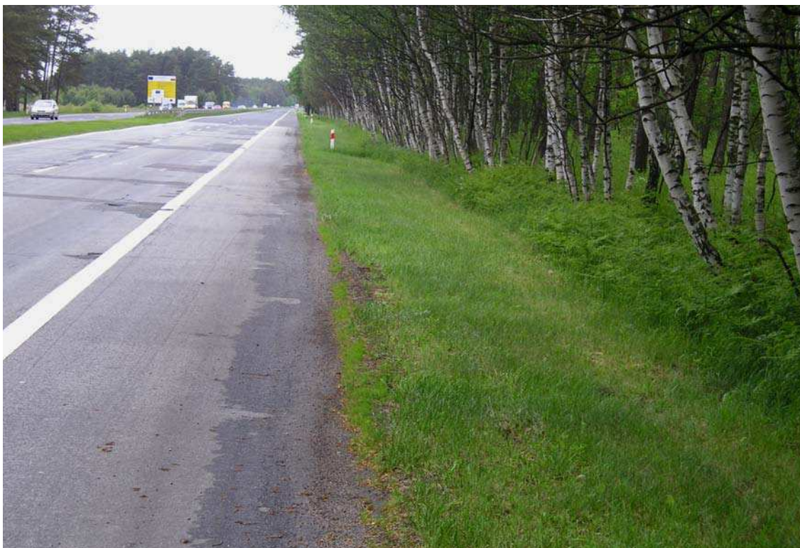
Fot. 63. Pobocza nieutwardzone zlokalizowane za poboczami utwardzonymi, pasami dodatkowymi, podlegają ocenie w systemie.
