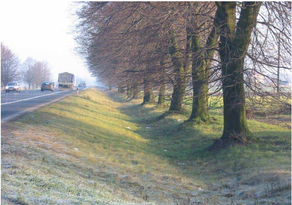
Fot. 8. Mulda trawiasta w dobrym stanie technicznym.
