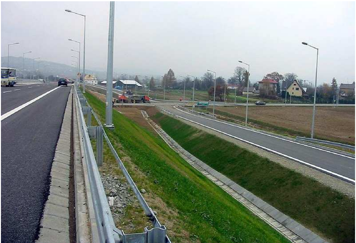
Fot. 68. Równoległe elementy odwodnienia – rynna oraz rów w stanie dobrym.
