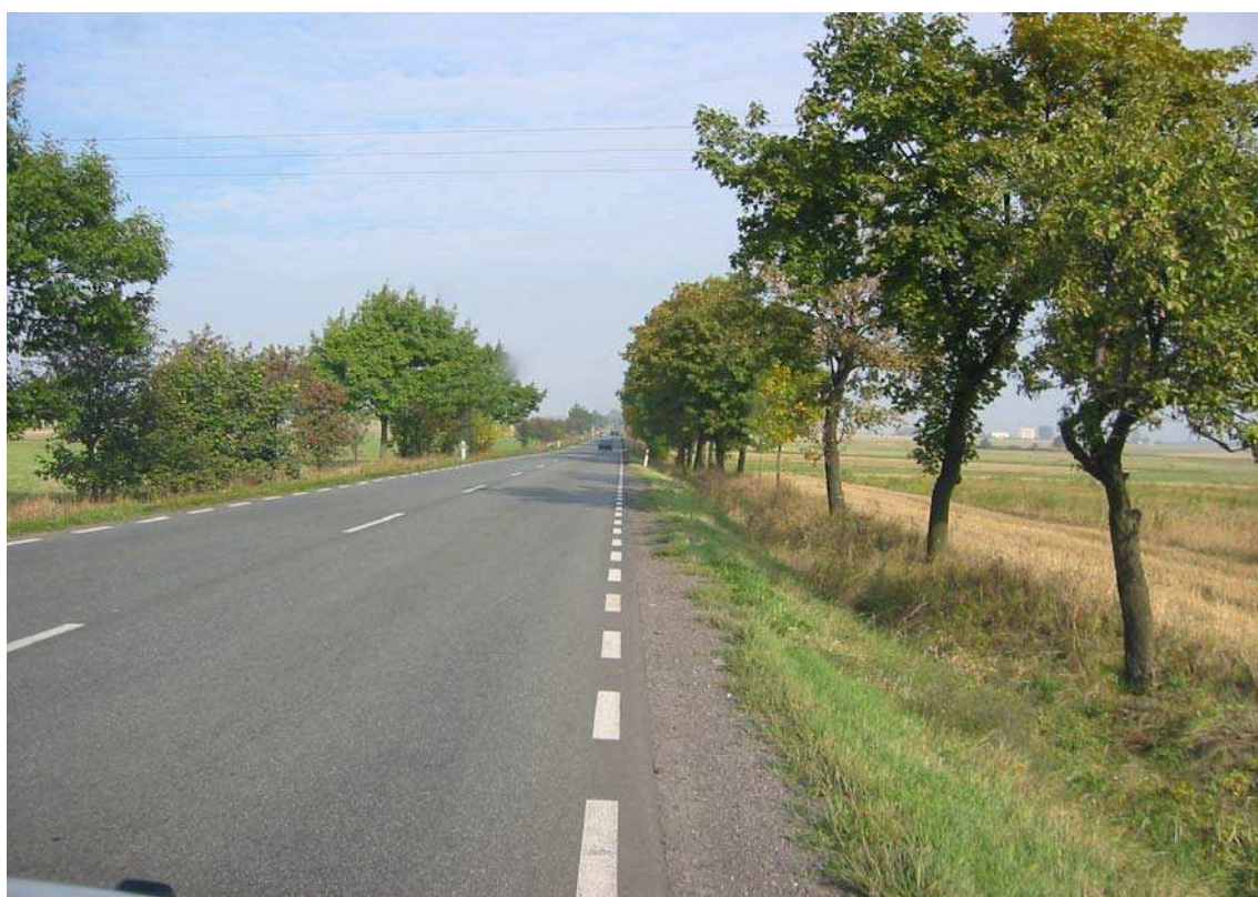
Fot. 41. Kolejny przykład pobocza w dobrym stanie technicznym
