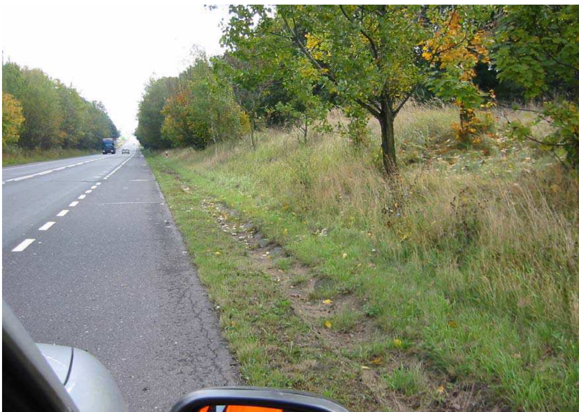
Fot. 18. Rynienka odprowadzająca zasypana i zarośnięta kępami roślinności.
