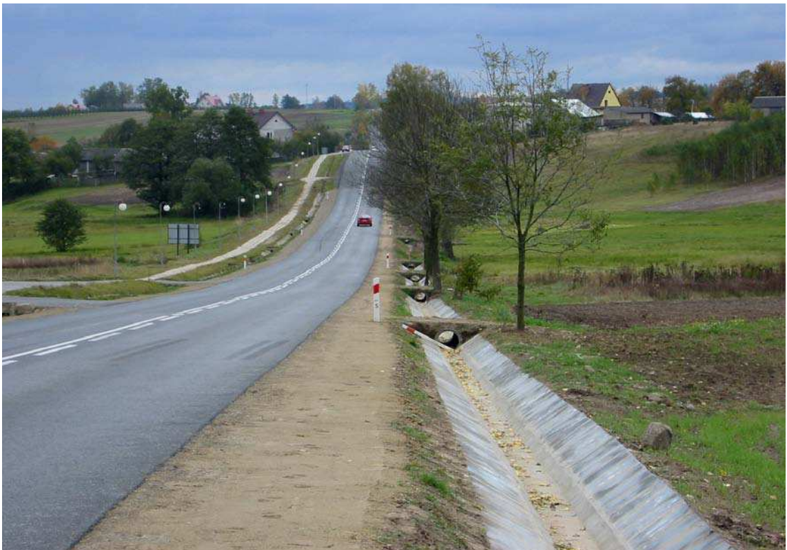
Fot. 6. Odnowiony ciąg systemu odwodnienia (drożne przepusty na wszystkich zjazdach).
