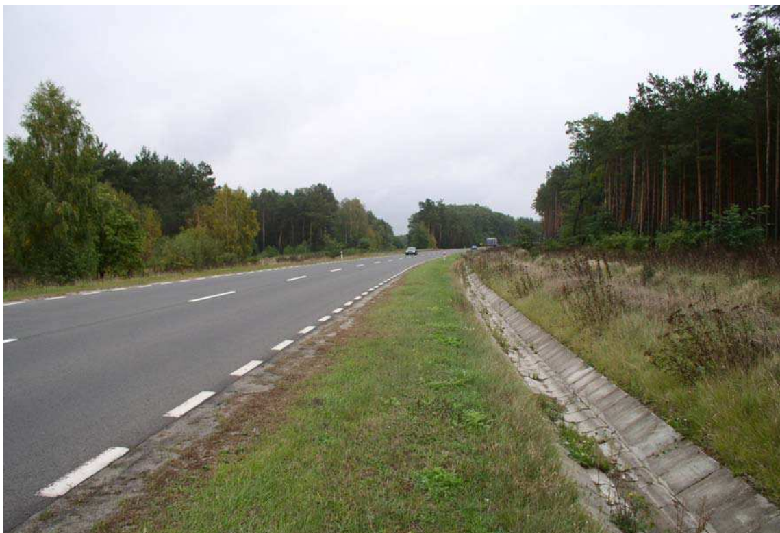
Fot. 11. Odwodnienie w stanie zadowalającym, między betonowymi prefabrykatami rosnące kępy roślinności, nie utrudniające odprowadzania wody.
