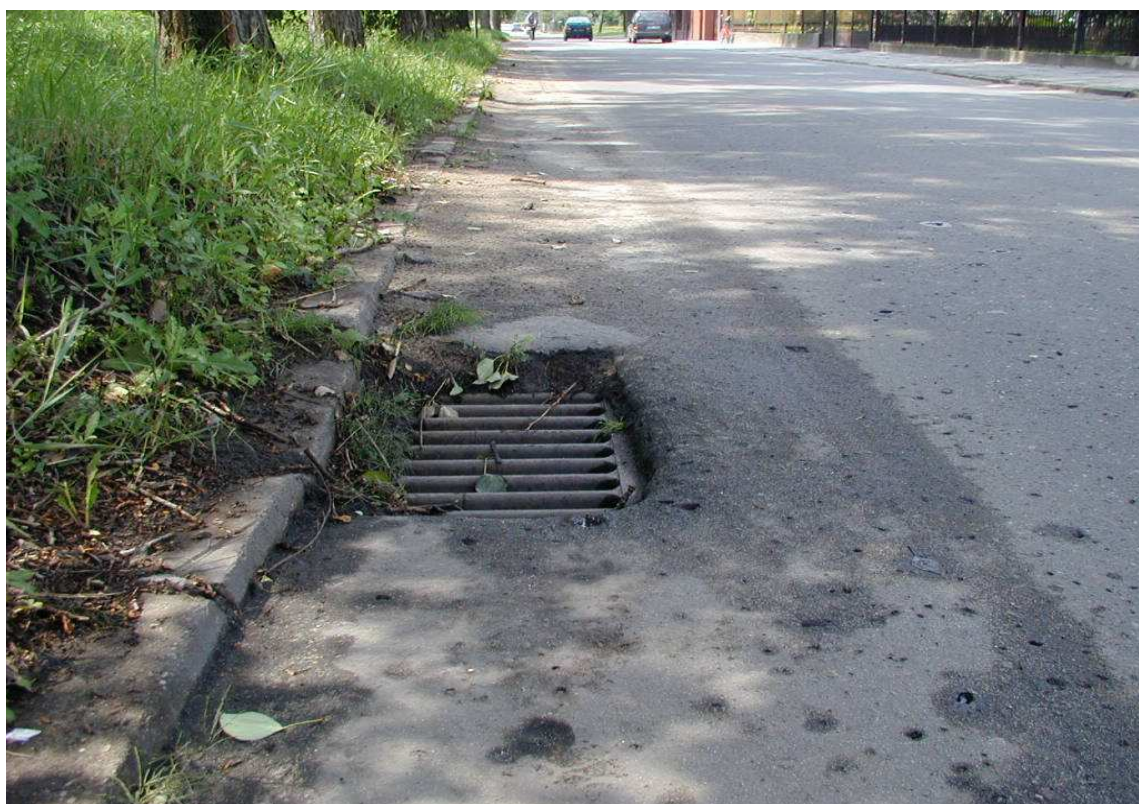
Fot. 35. Pomimo obniżenia poziomu kratki studzienki kanalizacyjnej względem nawierzchni jezdni, odwodnienie jest drożne – stan zadowolający.
