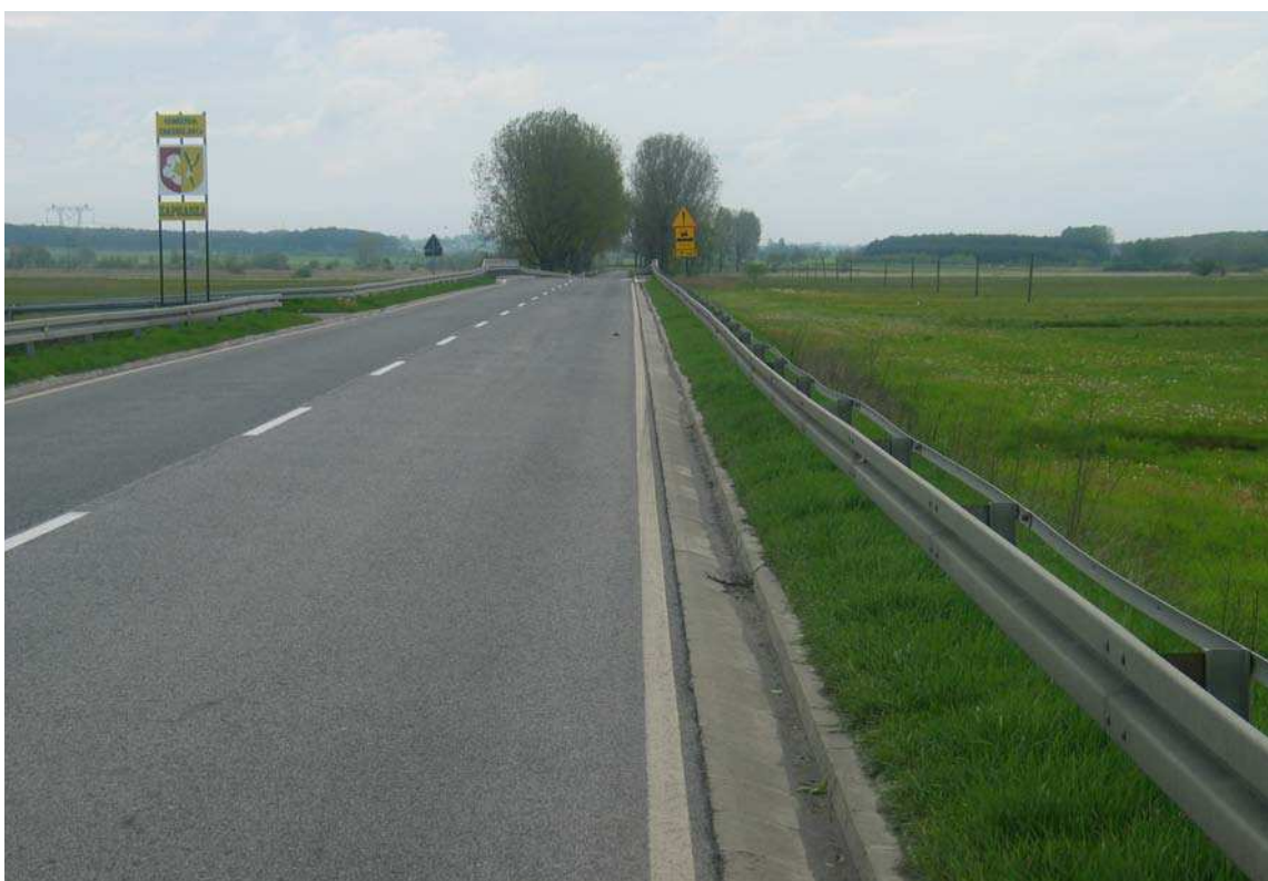
Fot. 3. Rynny odprowadzające w dobrym stanie technicznym.
