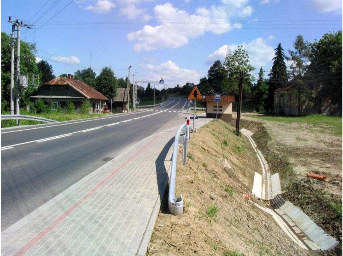
Fot. 67. Równoległe elementy odwodnienia – studzienka oraz rów w dobrym stanie technicznym.
