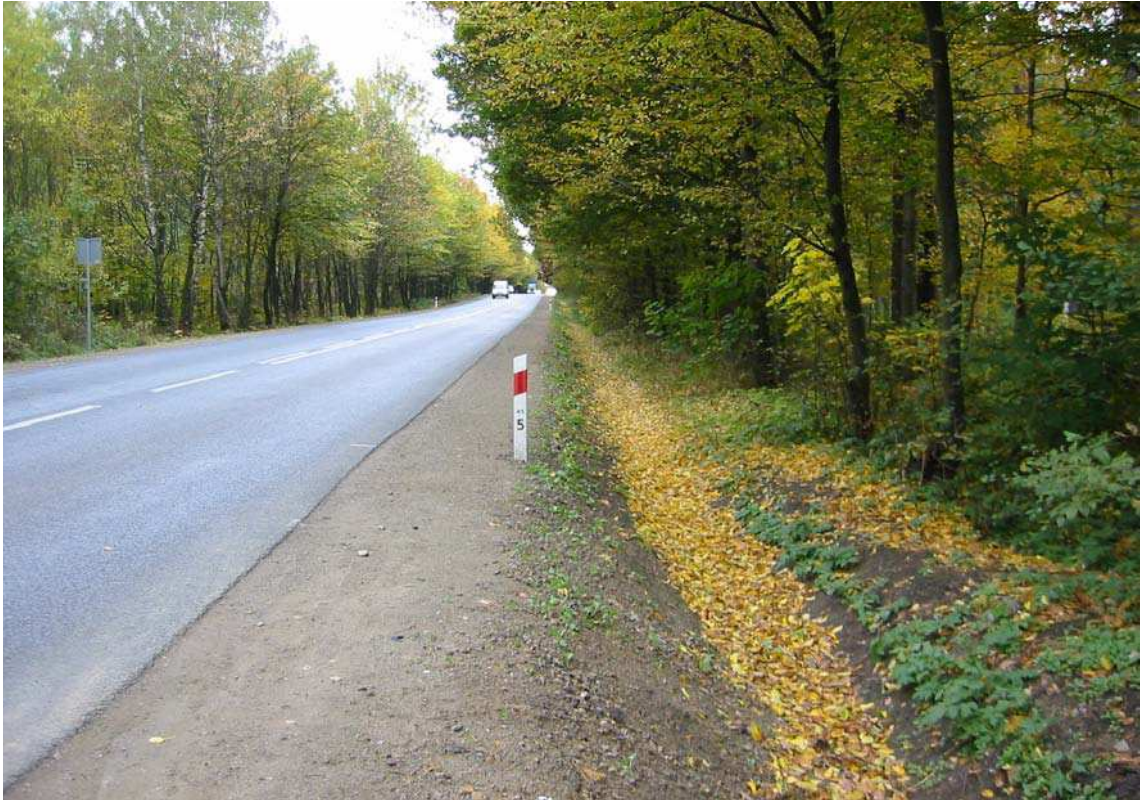
Fot. 44. Pobocze w stanie zadowalającym, uskok nie przekracza 5 cm.
