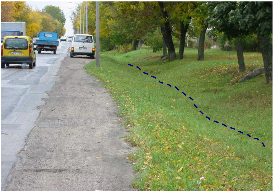
Fot. 22. Mulda o nieregularnej linii dna.
