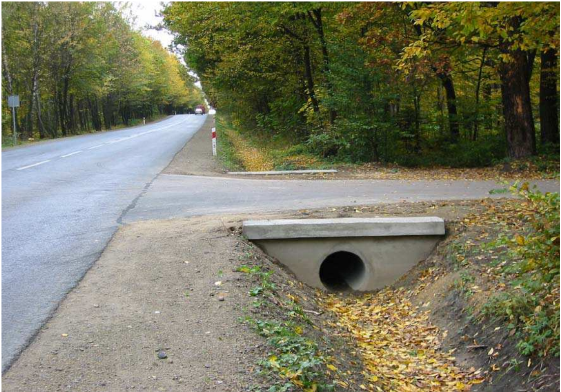
Fot. 7. Przepust w dobrym stanie technicznym.
