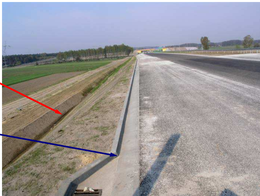
Fot. 65. Przykład występowania równoległych elementów odwodnienia wzdłuż drogi.
