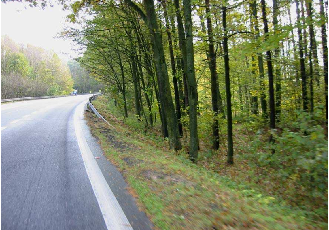
Fot. 71. Przykład odwodnienia naturalnego (droga wyniesiona na nasypie).
