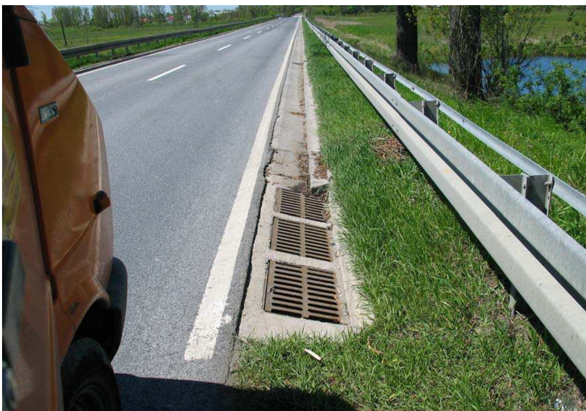
Fot. 4. Rynna przykrawężnikowa zakończona wpustem z kratką ściekową.
